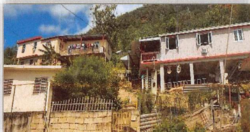
Residencias en zancos en las laderas del Municipio de Trujillo Alto (Análisis de Riesgo, Vulnerabilidad e Impacto de ISP)
