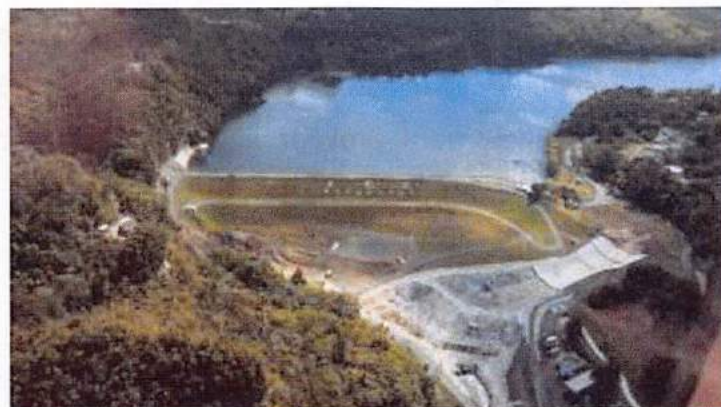
Represa Guajataca reparada. Foto Diciembre 2020
