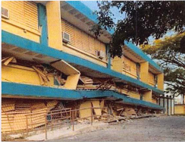
Escuela Agripina Seda en Guánica colapsó sobre sus cimientos
