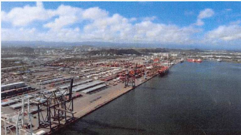
Área operacional de TOTE, Luis Ayala Colón y Trailer Bridge
