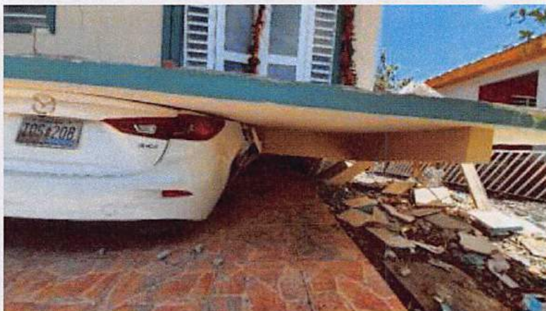
Las casas en zancos o columnas más vulnerables cayeron directamente al suelo
