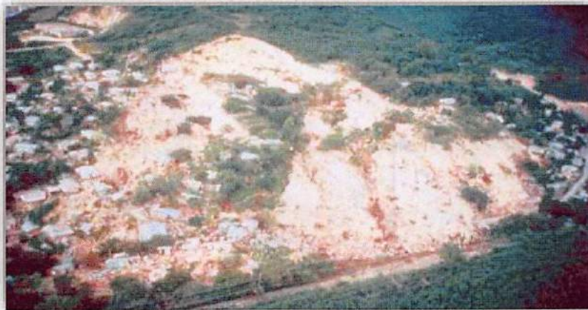
Derrumbe de Barrio Mameyes, Ponce Puerto Rico, 1985 (180 muertos aprox.)
