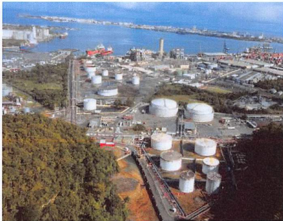
Tubería de transferencia de Total Petroleum: .68 millas
